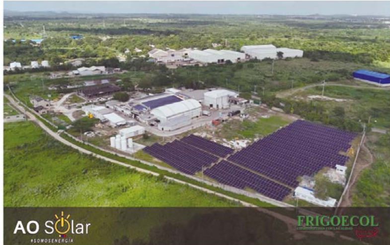
Figura 1. Planta solar fotovoltaica Frigoecol. Fotografía suministrada por AO SOLAR.
