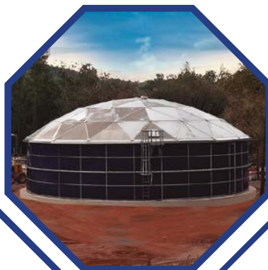
TANQUES DE ALMACENAMIENTO
